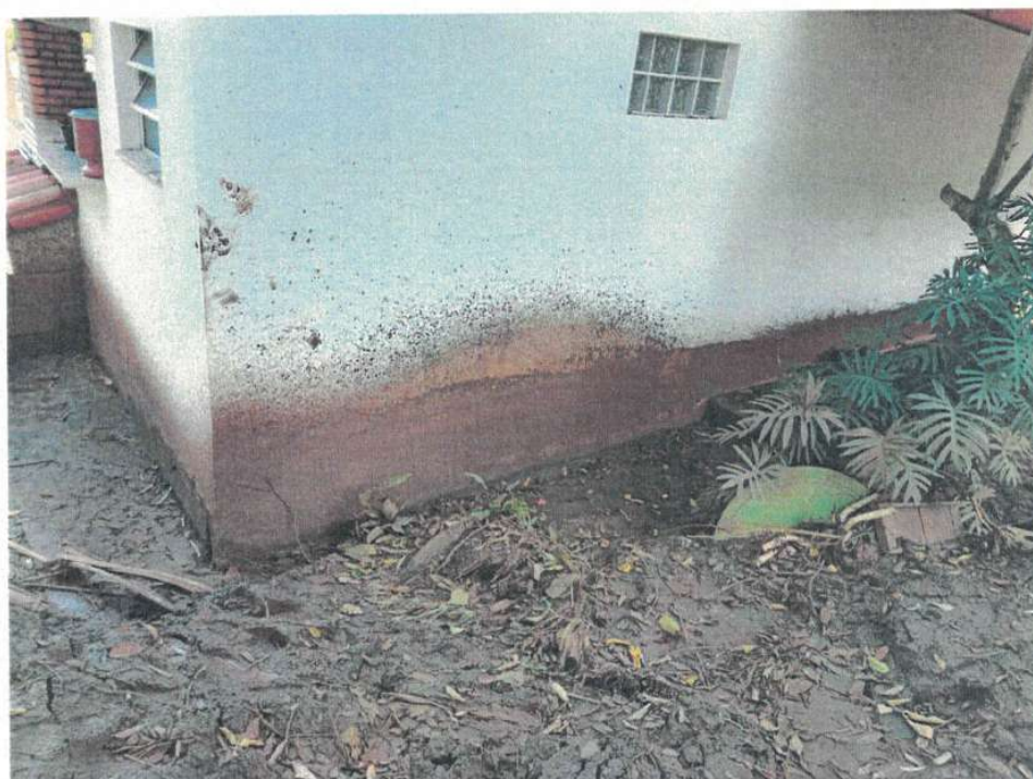
Figura 10 - Vista Geral da área externa.
