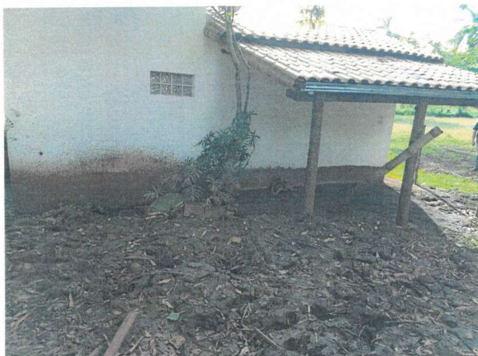
Figura 11 - Vista Geral da área externa.
