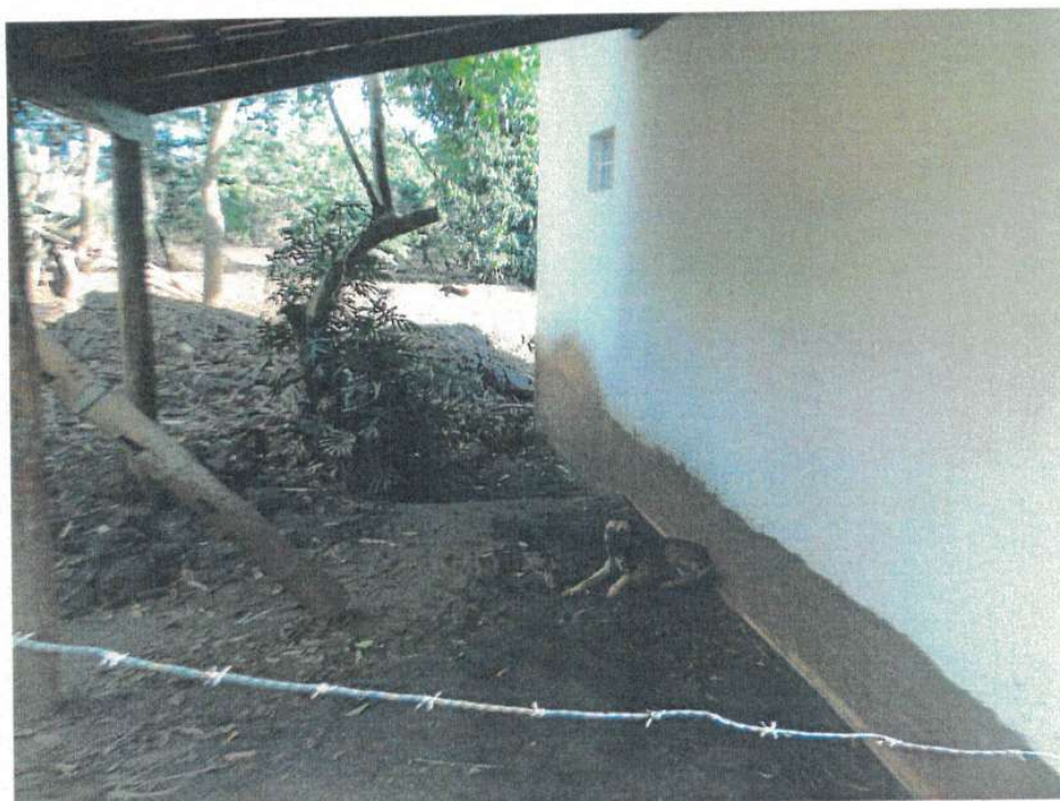
Figura 12 - Vista Geral da área externa.
