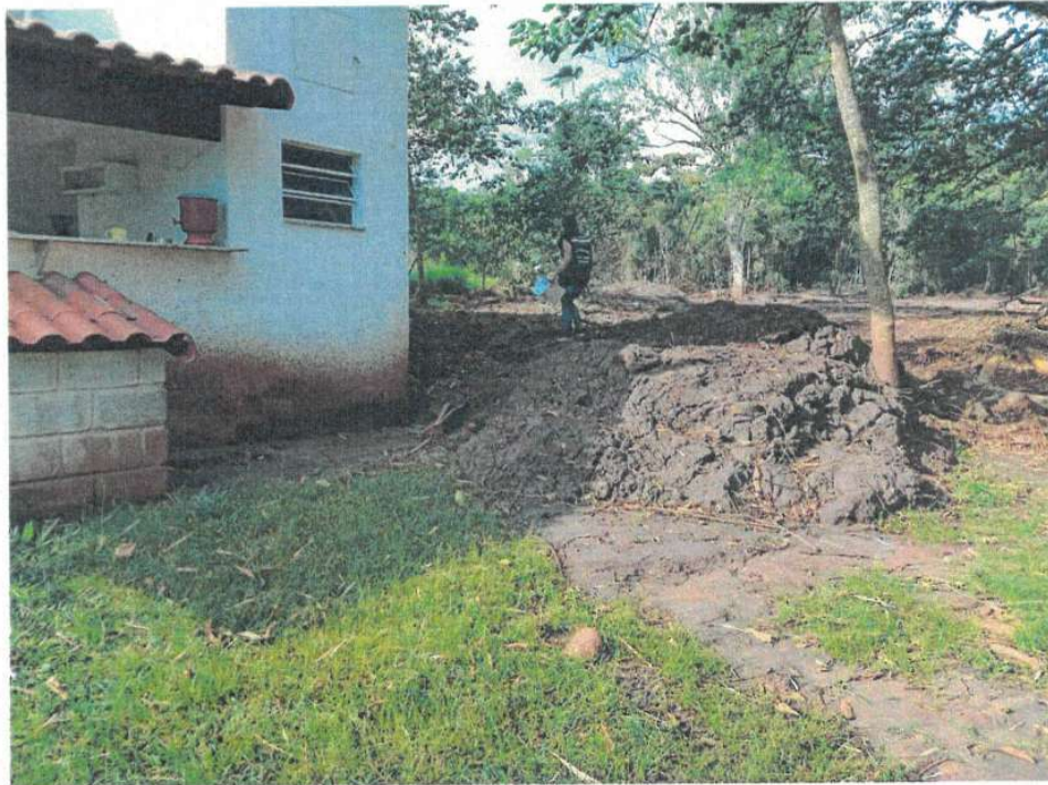
Figura 6 - Vista Geral da área externa.
