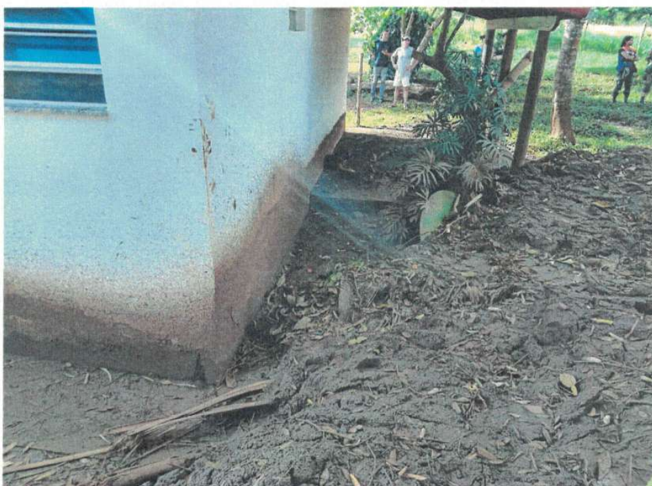
Figura 9 - Vista Geral da área externa.
