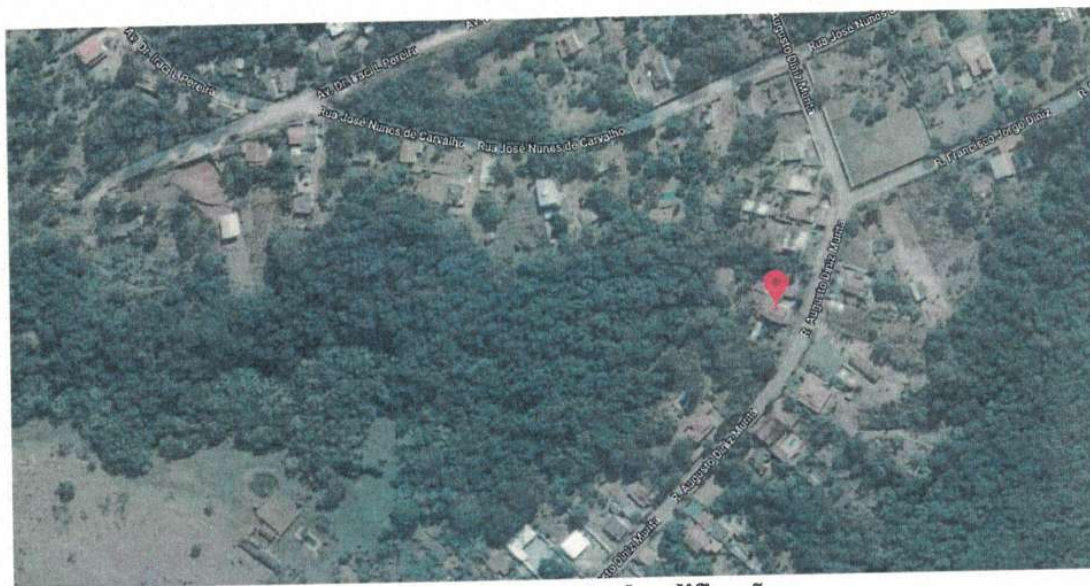
Figura 1 – Localização da edificação.
