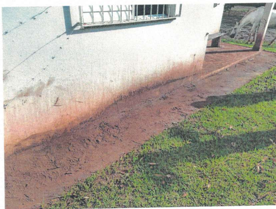
Figura 3 - Vista Geral da área externa.
