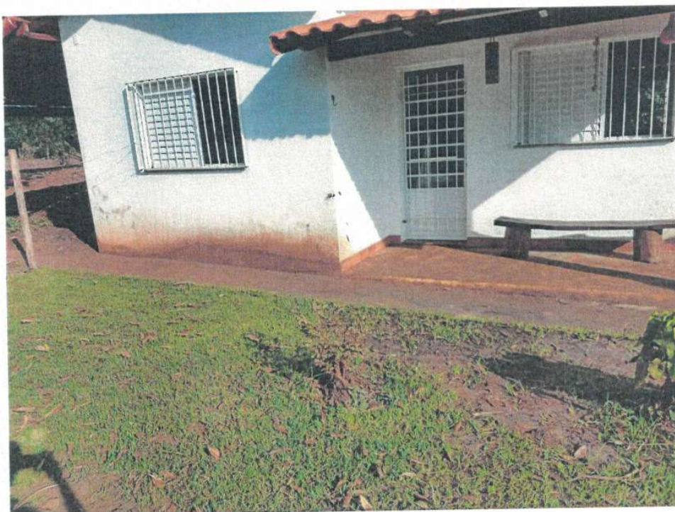
Figura 2 - Vista Geral da área externa.
