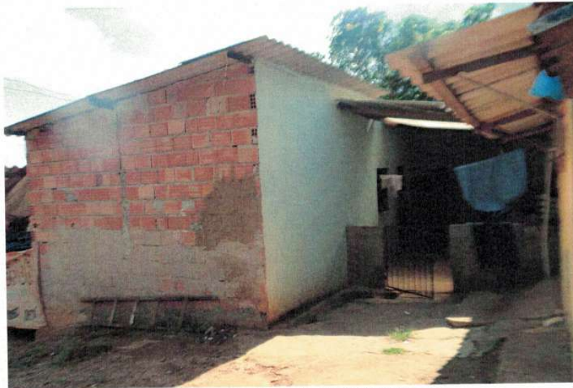
Figura 1 - Fachada da Edificação
