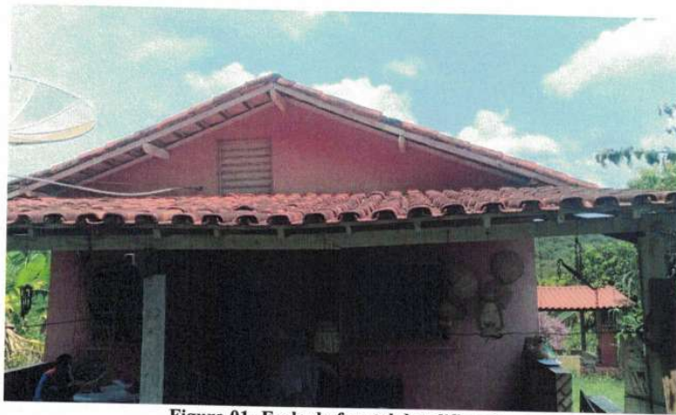
Figura 01- Fachada frontal da edificação.
