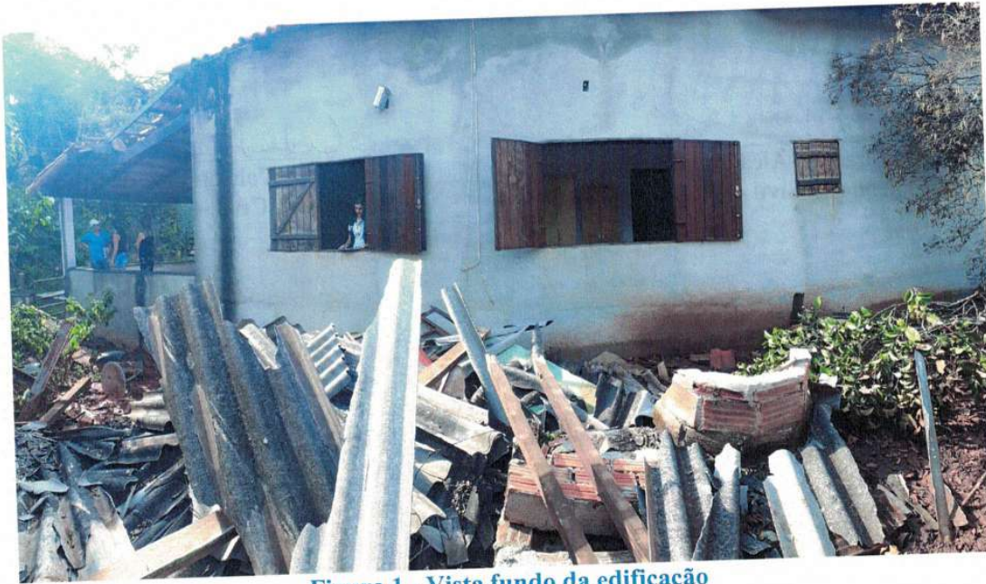
Figura 1 - Vista fundo da edificação
