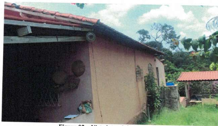
Figura 02 – Vista lateral da edificação.
