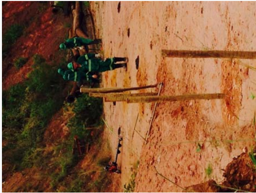
Instalação de cercas para restrição de acesso dos animais ao rio
