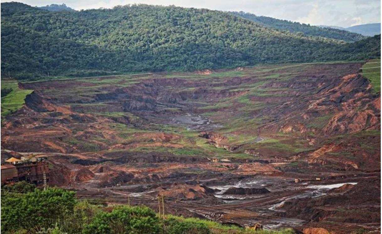
Foto 3-2: Área declivosa onde é necessária a remoção do rejeito de minério e a regularização do terreno, permitindo uma estabilidade mínima para a adoção das ações de restauração florestal. Bacia do ribeirão Ferro-Carvão, Brumadinho, MG, abril/2019.
