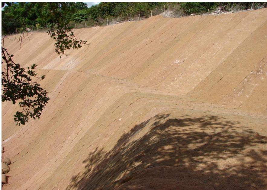
Foto 3-9: Exemplo de talude reconformado e recoberto por biomanta antierosiva. Este exemplo pode ser utilizado nas superfícies declivosas da antiga Barragem B I. Local: Recôncavo baiano.
