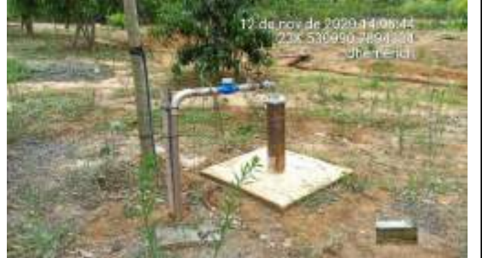
Foto 08: Poço Artesiano perfurado pelo proprietário
