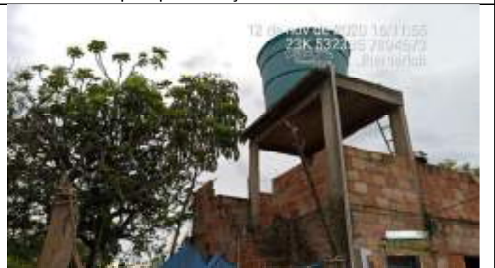
Foto 06: Reservatório da propriedade
