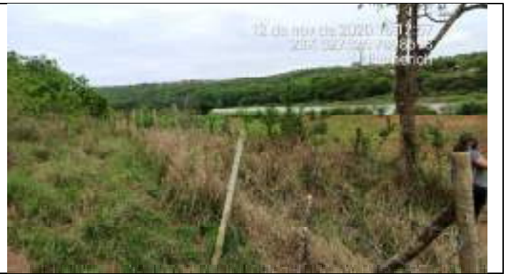
Foto 14: Isolamento do rio Paraopeba com cercamento realizado pela Vale
