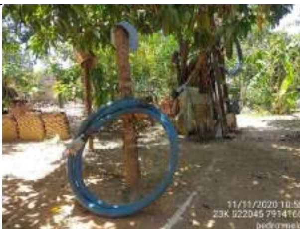
Foto 08: Mangotes de captação água Rio Paraopeba.
