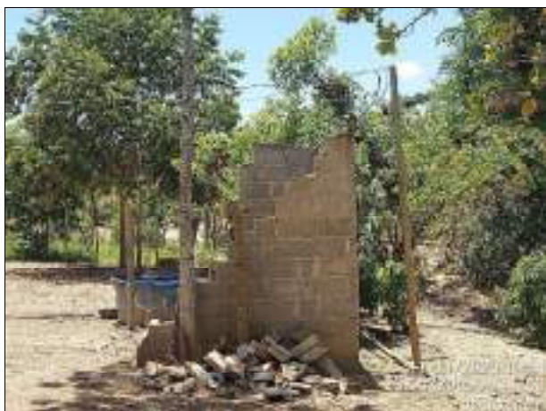
Foto 07: Poço Artesiano Comunitário.
