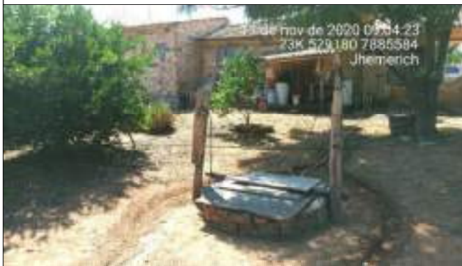
Foto 03: Cisterna no Lote
