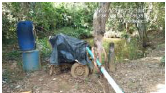
Foto 10: Bomba de Irrigação em propriedade Arrendada por Leandro
