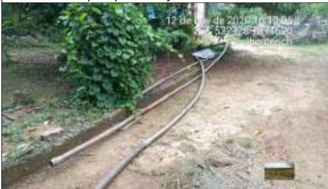
Foto 07: Canalização da Irrigação do córrego Ribeirão das Pedras
