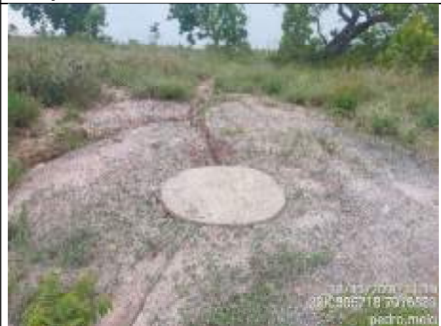
Foto 04: Poço Artesiano Comunitário.
