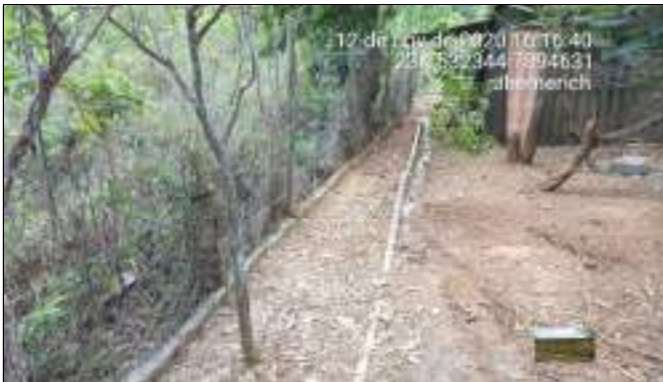
Foto 09: Canalização da Irrigação do córrego Ribeirão das Pedras
