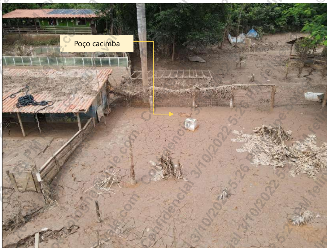
Foto 2 – Registro na comunidade de Taquaras evidenciando poço cacimba soterrado pelos sedimentos carregados pela inundação (02/02/2022).
