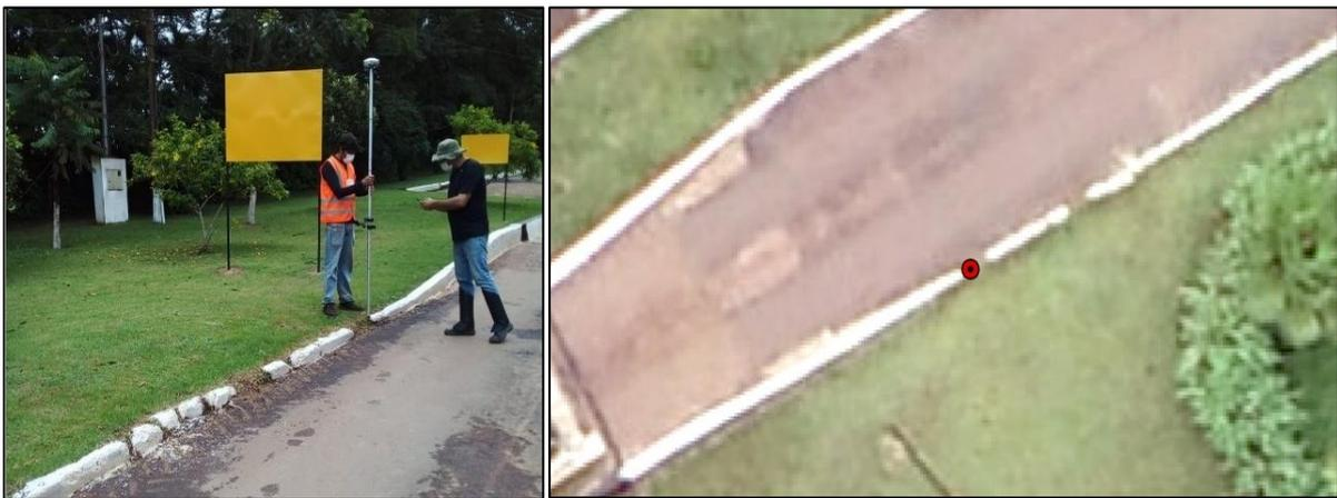
*Figura 9 - Medição de ponto de controle utilizando feição existente no terreno (esquerda) e o correspondente apontamento do ponto de controle fotoidentificado na imagem aérea (direita).*
